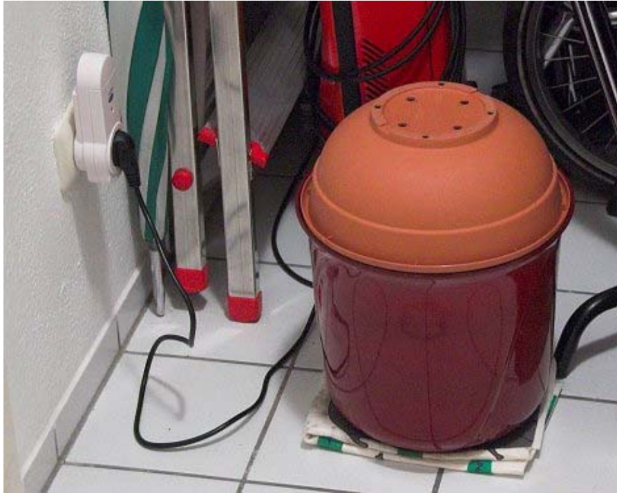
Der Keramik-Übertopf, in dem sich die Pumpe befindet. Die Pumpe ist an eine Funksteckdose angeschlossen.
